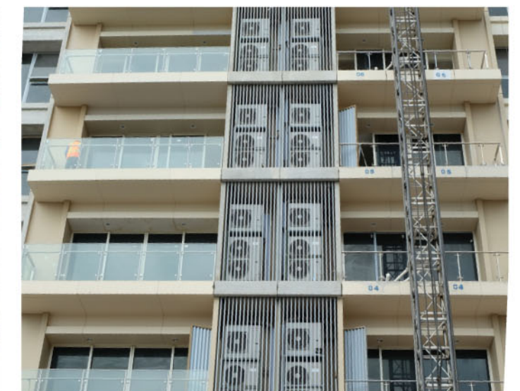
Pekerjaan Detail Panel AC
