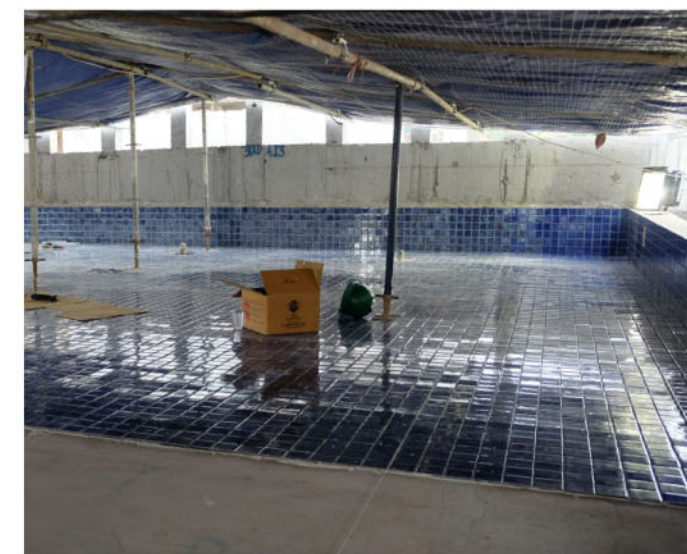
Progress pembangunan Kolam Renang
