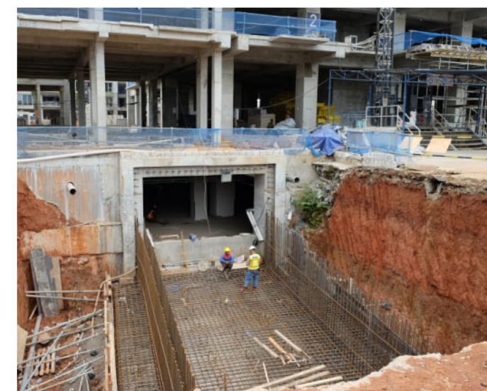
Terowongan menuju Pondok Indah Mall 3
